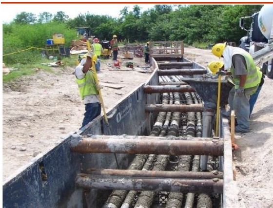
Figure 12-2 Conduit Placement
